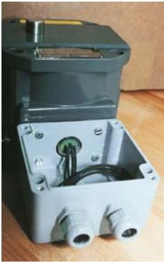
Traversée de cloison dans un boîtier de jonction Ex
